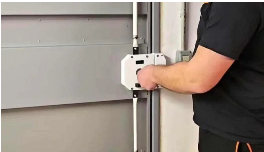
Jg espace serrurier vitrier 91 etampes photos du proprietaire
