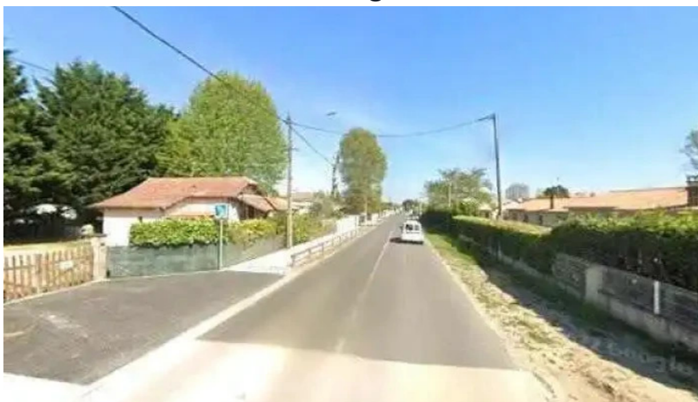
Steel atelier tout
