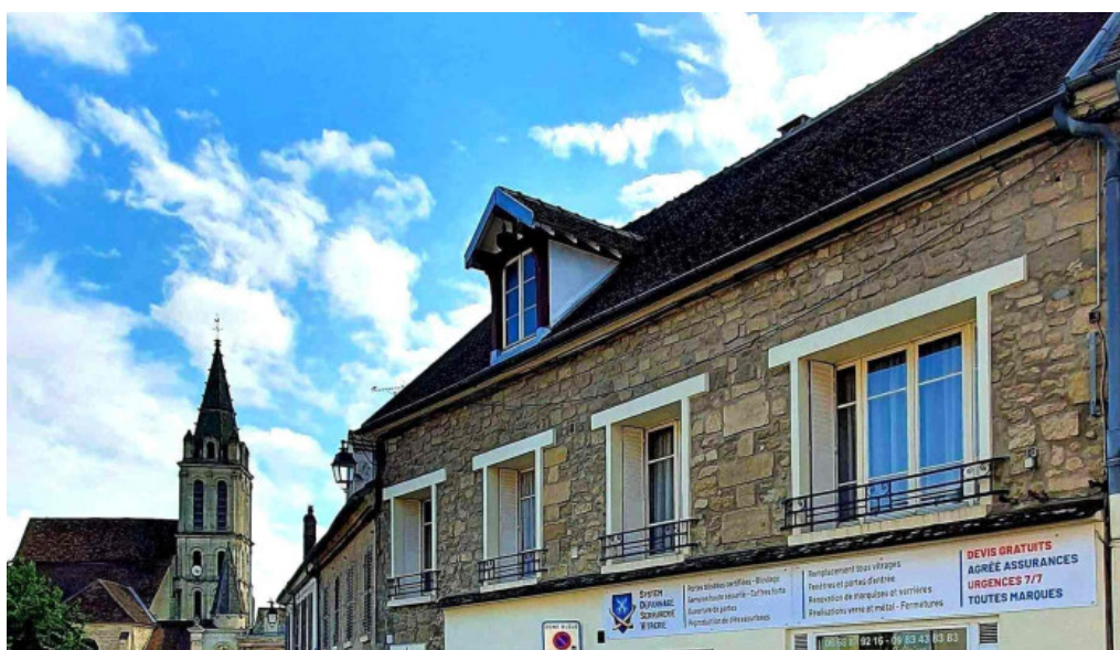
System depannage serrurerie vitrerie tout
