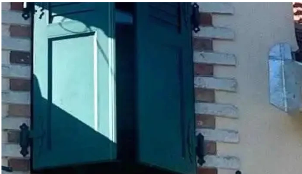
Serrurerie metallerie du provinois tout
