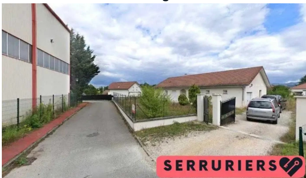
Serrurerie du guiers le pont de beauvoisin
