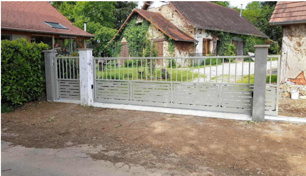
Borderie serrurerie metallerie exterieur
